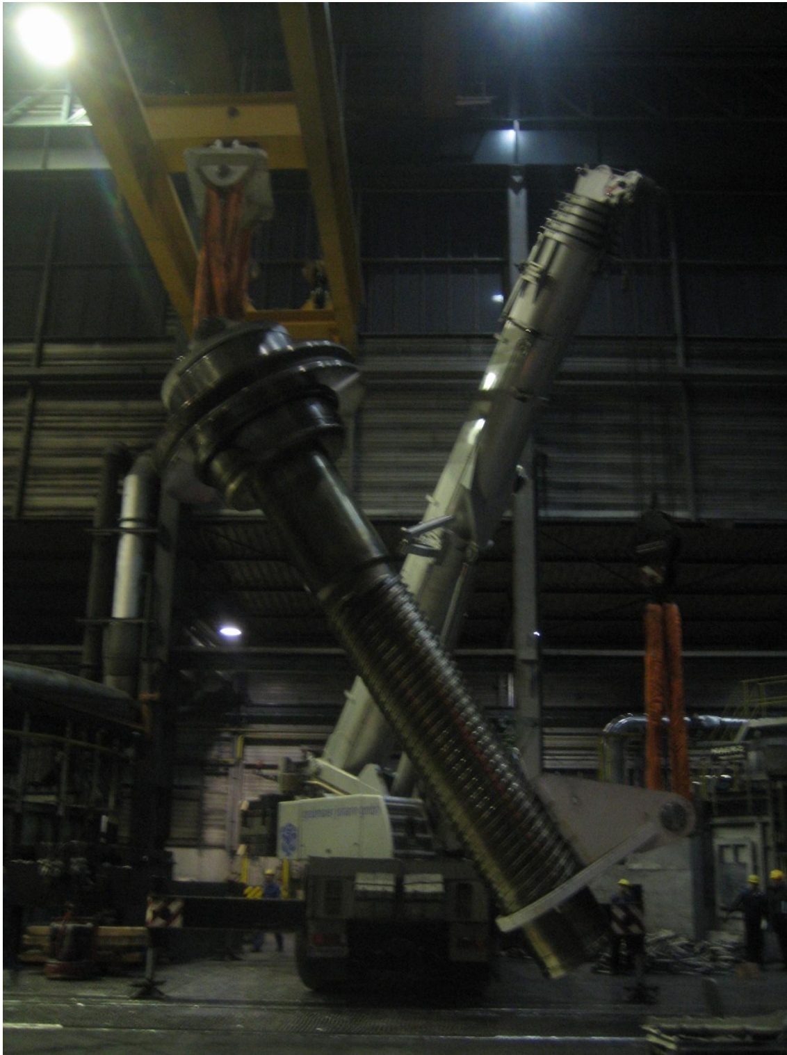
Umlegevorgang mit Hilfe eines Autokranes. Der Hauptkran fährt nach Vorgabe der kinematischen Berechnung und senkt die Spindel in horizontale Lage.
