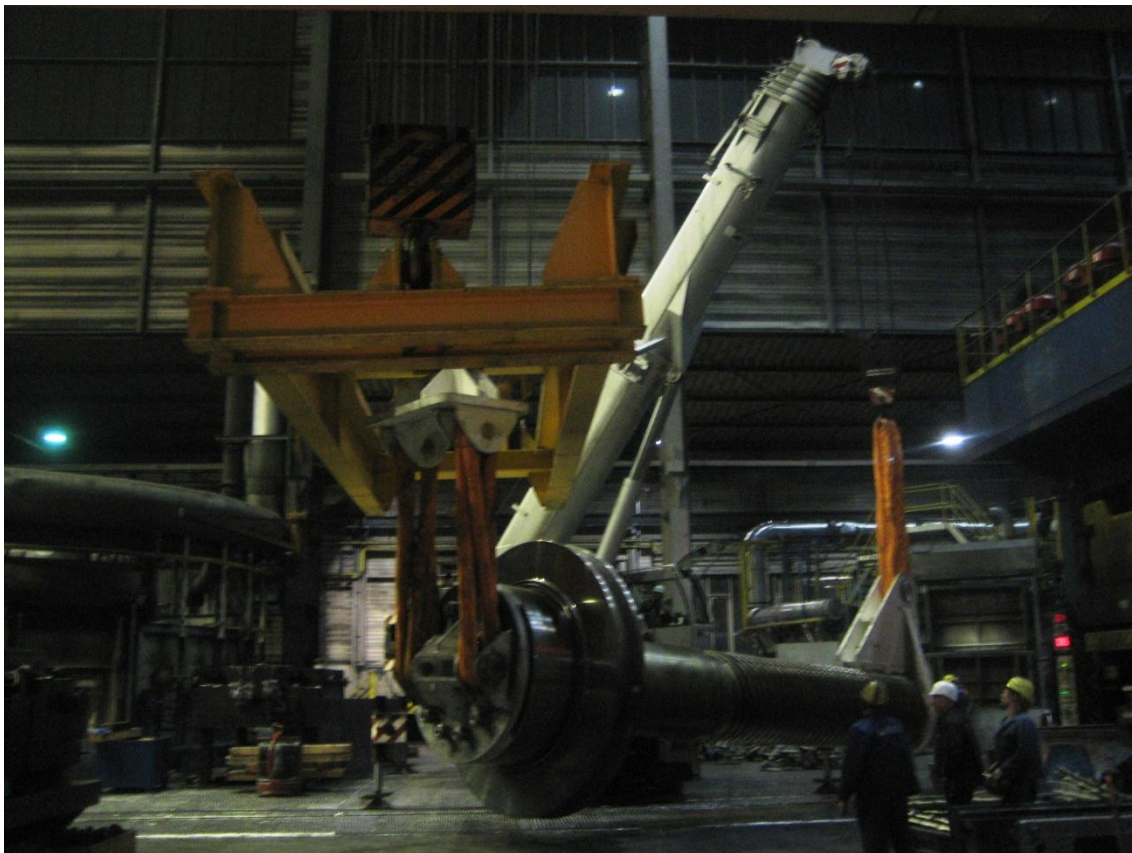
Die Spindel ist in horizontaler Position und wird auf den Hilfsbock gelegt.
